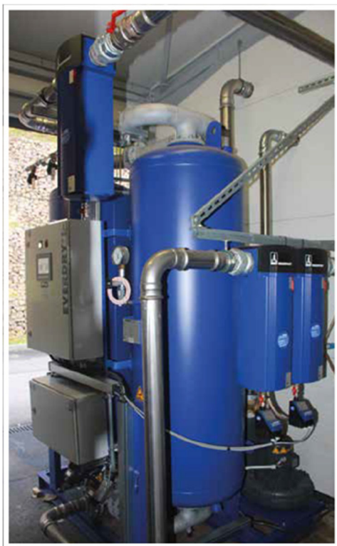
Srdcem systému na úpravu stlačeného vzduchu je adsorpční sušička s teplou regenerací EVERDRY® typu FRA-V
