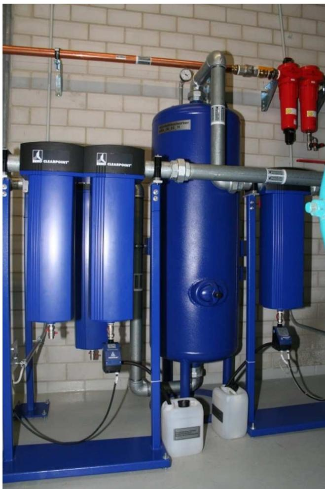
Für die Abscheidung von Partikeln sind anschließend CLEARPOINT-Fein- bzw. Feinstfilter von BEKO mit einem Abscheidegrad von 0,1 µm und 0,01 µm in der Druckluftleitung installiert. Luft-
