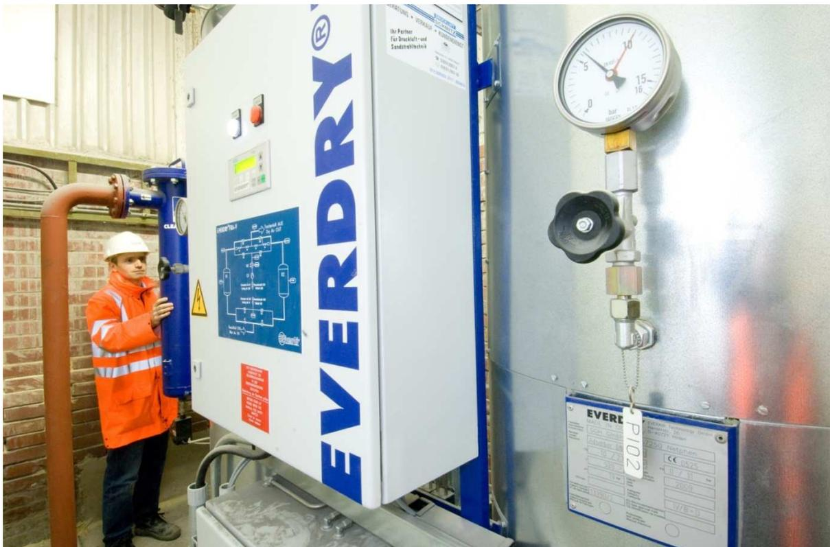
Durch den Druckbetrieb des Regenerationsgebläses entsteht ein Temperaturzugewinn, der sich positiv auf den Leistungsbedarf des Erhitzers auswirkt. Der Gebläseluftstrom verdampft die im Trockenmittel aufgenommene Feuchtigkeit und wird anschließend mit dem Luftstrom in die Atmosphäre geleitet. Die Desorption läuft energetisch optimiert im Gegenstromverfahren ab.
