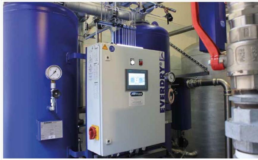
*Teilansicht des warmregenerierenden Adsorptionstrockners EVERDRY Typ FRA-V*
