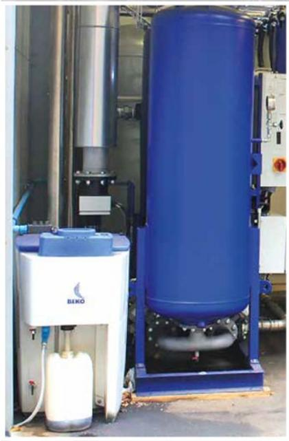
*Der installierte ÖWAMAT Öl-Wasser-Trenner sammelt und behandelt aus dem Druckluftsystem des Kunden austretendes dispergiertes Kondensat, und zwar unabhängig vom Kompressoröl.*
