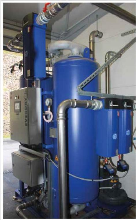
*Der warmregenerierende Adsorptionstrockner EVERDRY Typ FRA-V ist das Herzstück der Druckluftaufbereitungsanlage*
