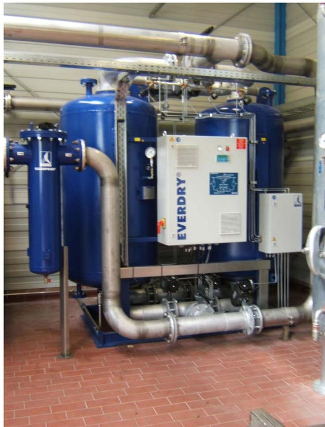
Da die Rohrleitungen der Druckluftanlage innerhalb des Werksgeländes über Rohrbrücken weitgehend im Außenbereich verlaufen, sind sie naturgemäß saisonal großen Temperaturschwankungen unterworfen. So muss zum Beispiel zum Schutz vor Nachkondensation und Einfrierungen im Winter ein Drucktaupunkt von besser als minus 40 °C gegeben sein. Um hier höchste Prozesssicherheit zu
