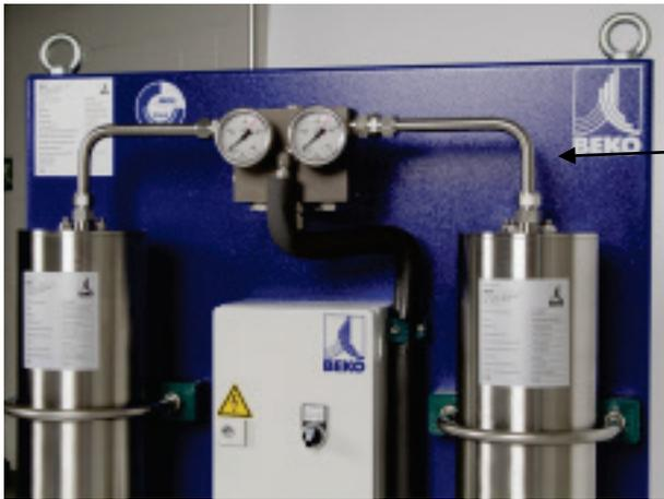
Demontieren Sie die Rohrleitung über den Adsorptionsbehältern.
