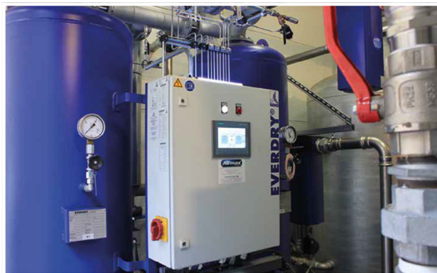
Vista parcial del secador de adsorción con regeneración de calor EVER-DRY® modelo FRA-V
