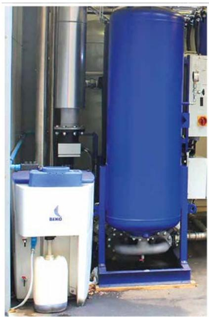
*Le système de traitement des condensats ÖWAMAT installé, permet de collecter et de traiter les condensats dispersés rejetés par l'installation d'air comprimé du client et ce, quelles que soient les huiles compresseur*
