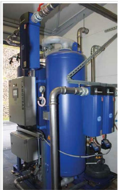
*Le sécheur par adsorption à régénération par apport de chaleur EVERDRY modèle FRA-V constitue la pièce centrale du système de traitement d'air comprimé*
