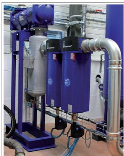
*L'ensemble composé de l'échangeur air/eau, du séparateur centrifuge et de la filtration CLEARPOINT ont permis d'abaisser la température de l'air comprimé de manière efficace tout en éliminant les particules solides, les poussières et l'huile contenues dans l'air comprimé*
