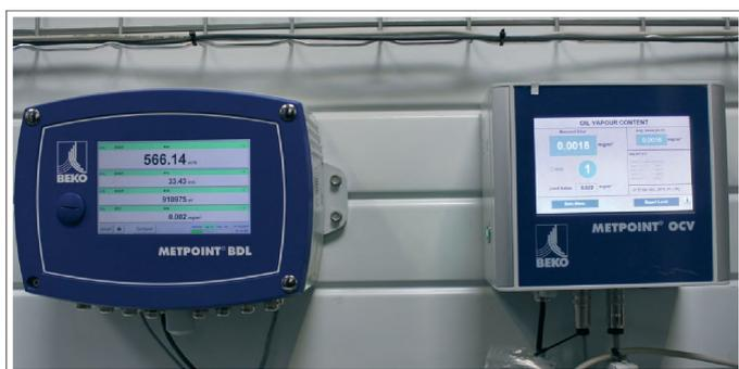
*Le terminal METPOINT BDL permet d'enregistrer le débit, la pression, le ratio Wh/m<sup>3</sup>, le PRSP et la teneur résiduelle en huile, etc., de les afficher et de les communiquer via un réseau Ethernet. Quant à l'analyseur de la présence d'huile résiduelle METPOINT OCV, il affiche des valeurs qui ont permis au client d'avoir la certitude de disposer d'un air comprimé de haute qualité pour son process, de classe 1 en huile selon ISO 8573-1.*
