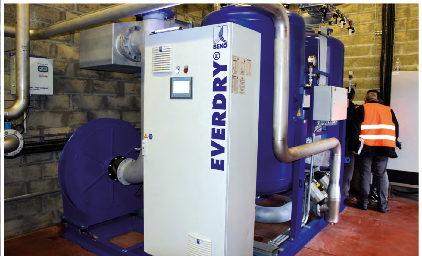
Le sécheur par adsorption à régénération par apport de chaleur EVERDRY® modèle FRL 5000, avec une capacité de séchage de 5000 m 3 /h et une pression de service de 6,5 bar, constitue le cœur de la nouvelle installation d'air comprimé.
