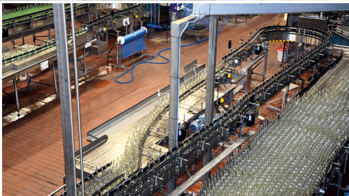
Ligne d'embouteillage chez Les Grands Chais de France à Landiras
