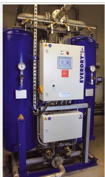
*Le sécheur par adsorption avec régénération par apport de chaleur EVERDRY modèle FRA-Vplus « zéro purge » constitue le "cœur" de la nouvelle installation de traitement d'air comprimé de MONIN.*
