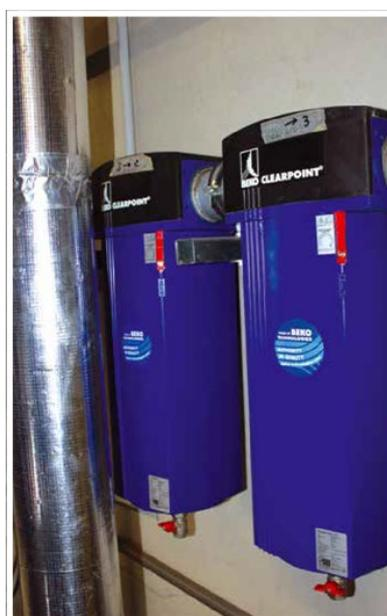
*L'ensemble de filtration CLEARPOINT protège le sécheur par adsorption avec régénération par apport de chaleur EVERDRY modèle FRA-Vplus « zéro purge » contre les impuretés contenues dans l'air comprimé telles que l'eau, l'huile liquide, ainsi que les particules solides comme les poussières*
