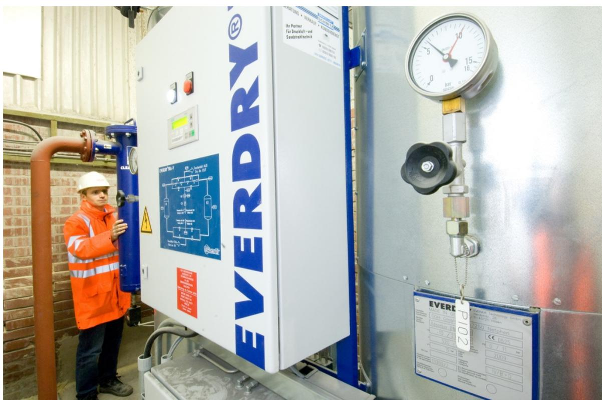
Le fonctionnement en mode pression de la soufflerie de régénération provoque un gain de température qui influence positivement le besoin en énergie du réchauffeur. Le flux d'air de la soufflerie vaporise l'humidité acquise dans l'absorbeur et est ensuite dirigé vers l'atmosphère. La désorption se fait à contre-courant, de manière optimisée du point de vue énergétique.
