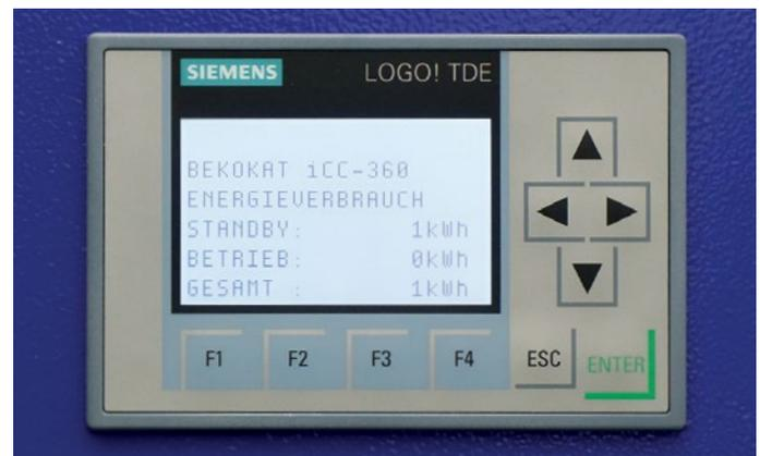
La conduite d'opérateur de l'unité de commande SIEMENS permet une utilisation simple et hautement fiable de l'installation ; elle permet également d'afficher les états de fonctionnement actuels, les avertissements ou les instructions pour l'opérateur.
