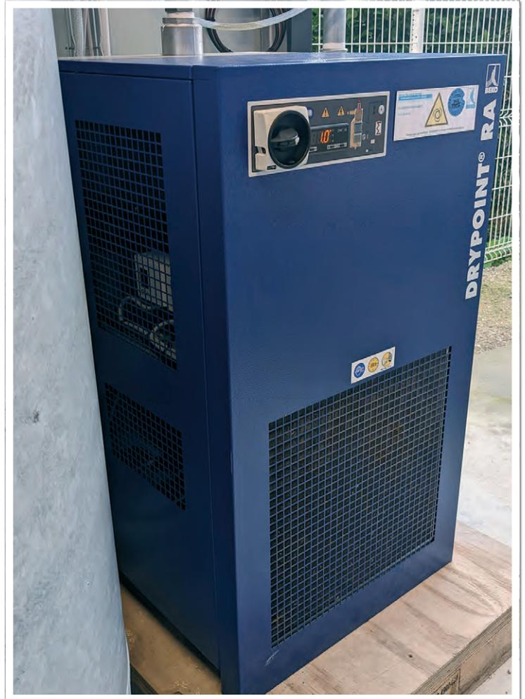
Les contraintes de l'installation du client imposaient la mise en place d'un sécheur frigorifique **DRYPOINT® RA 630 AC**, solution optimale pour protéger de manière fiable, efficace et économique, le réseau d'air comprimé du client contre toute formation de condensation, source de corrosion des tuyauteries, des défaillances des équipements, etc., jusqu'à une température de +3 °C.
