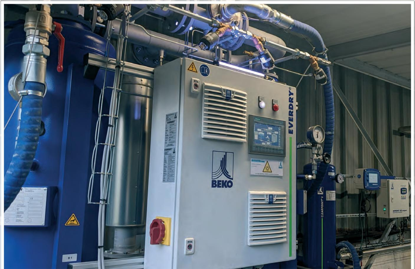
Le sécheur par adsorption à régénération par apport de chaleur **EVERDRY® FRA-Vplus 600C** constitue l'élément central de la solution de traitement d'air comprimé sur mesure proposée par **BEKO TECHNOLOGIES** à Laiterie Le Gall.
