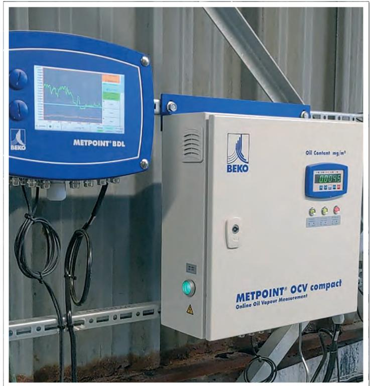
Grâce au terminal enregistreur de données **METPOINT® BDL**, le client peut suivre efficacement et en temps réel les paramètres de son installation d'air comprimé (débit, pression, PRSP, consommation d'air comprimé, teneur résiduelle en hydrocarbures, etc.). Quant à l'analyseur **METPOINT® OCV compact**, il surveille et mesure en continu la teneur résiduelle en hydrocarbures contenus dans l'air comprimé du client, et lui permet ainsi d'attester de la qualité d'air utilisé pour son process.
