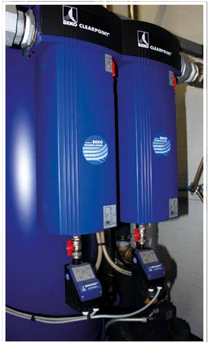
L'ensemble de filtration CLEARPOINT® composé d'un filtre dévésiculateur, d'un filtre déshuileur et d'un filtre anti-poussière permet au client d'éliminer efficacement l'eau et l'huile liquide ainsi que les particules solides (poussières...) contenues dans son réseau d'air comprimé.
