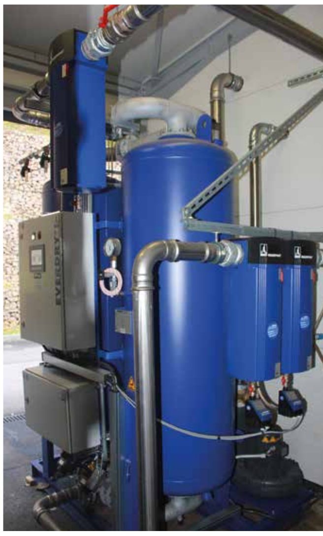
Le sécheur par adsorption à régénération par apport de chaleur EVERDRY® modèle FRA-V constitue la pièce centrale du système de traitement d'air comprimé
