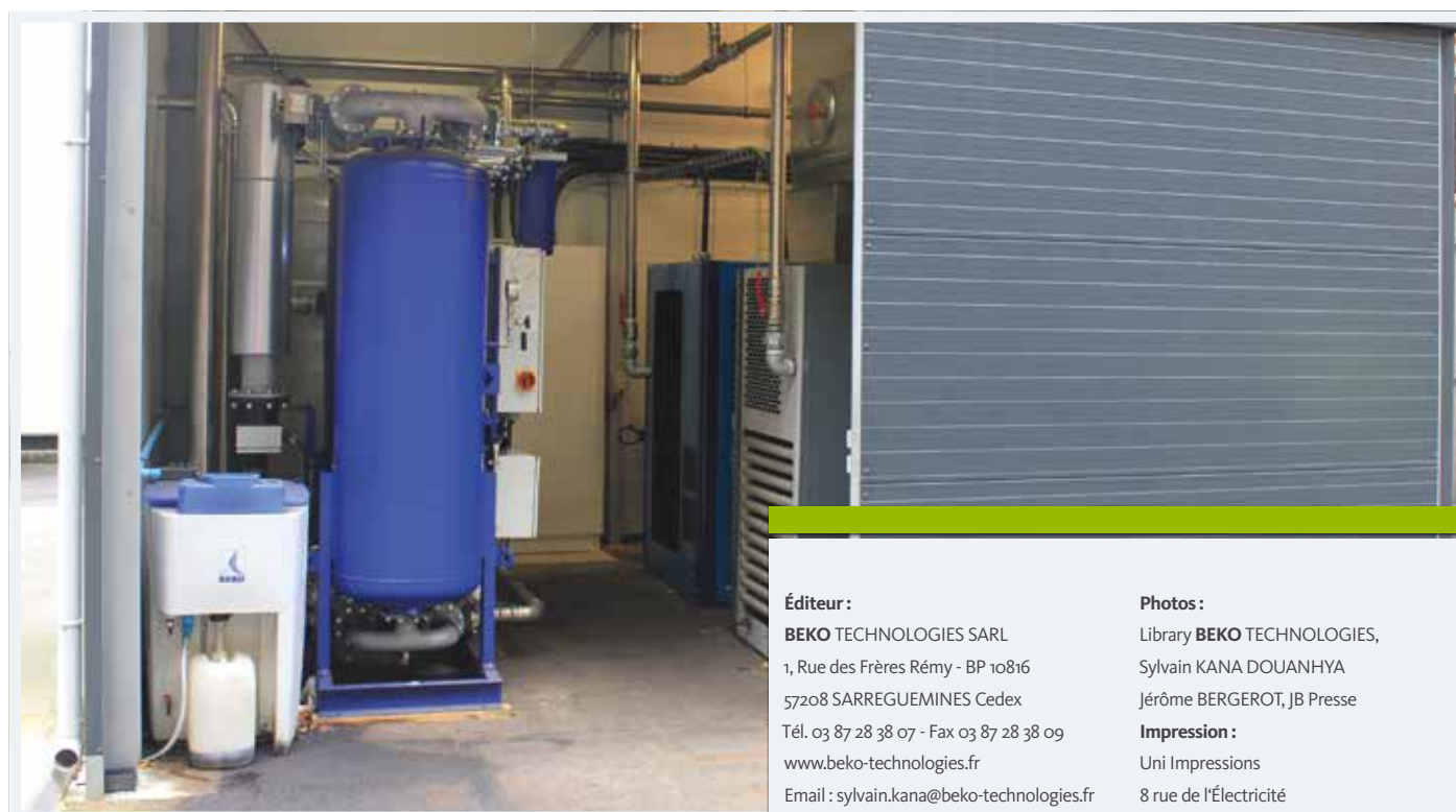
Afin de garantir le bon fonctionnement de la centrale de production d'air comprimé du client, 2D Pneumatic a construit un nouveau local compresseurs-sècheur dédié.
