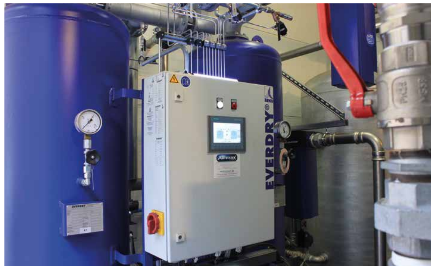
Vue partielle du sécheur par adsorption à régénération par apport de chaleur EVERDRY® modèle FRA-V
