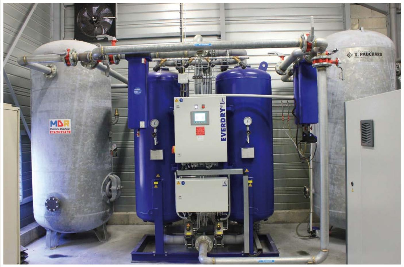
Le sécheur adsorption EVERDRY® type FRA-V (zéro Purge), installé chez SAINT-GOBAIN WEBER associé à une ligne complète de filtration CLEARPOINT® constitue le cœur du nouveau système de traitement d'air comprimé tout en produisant de l'air comprimé de qualité et en contribuant à la réduction des coûts d'exploitation.
