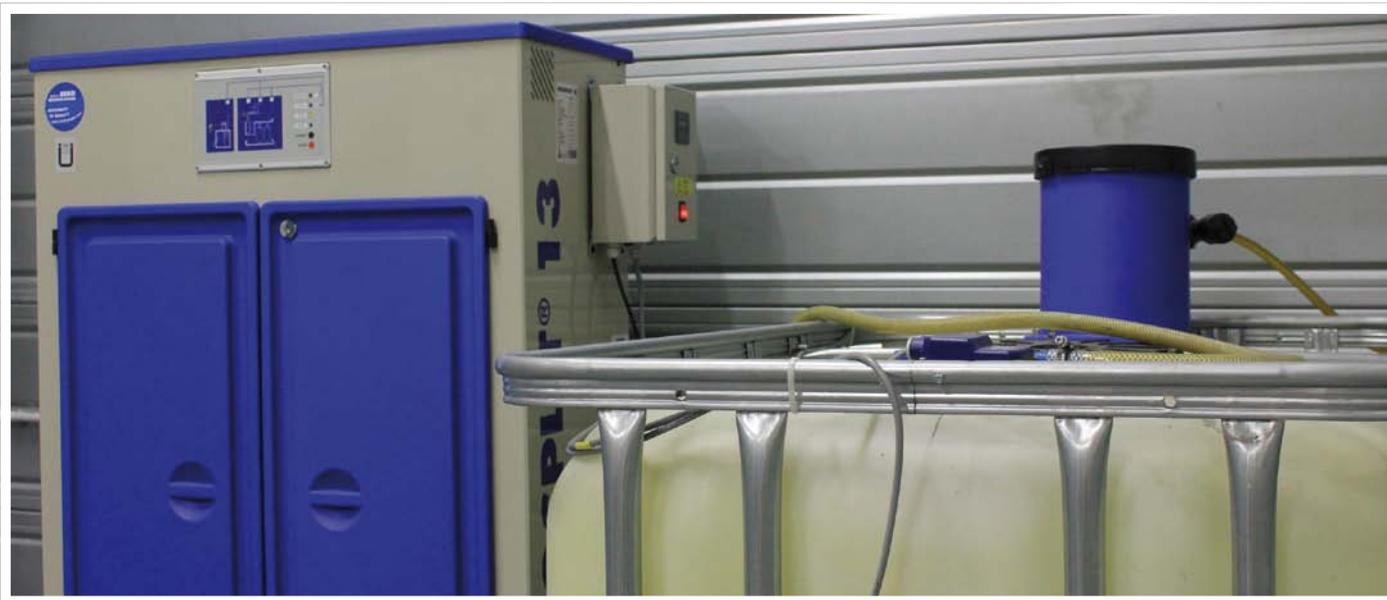
Grâce au système BEKOSPLIT® 13 installé, le client collecte et traite directement sur site les condensats émulsifiés rejetés par l'installation d'air comprimé et ce, quelles que soient les huiles compresseurs.
