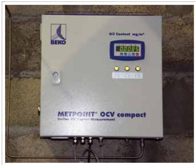
L'analyseur METPOINT® OCV compact aide le client à mesurer et à surveiller en permanence son réseau d'air comprimé quant à la teneur en huile résiduelle. Il permet donc d'attester la qualité et la pureté de son air comprimé.
