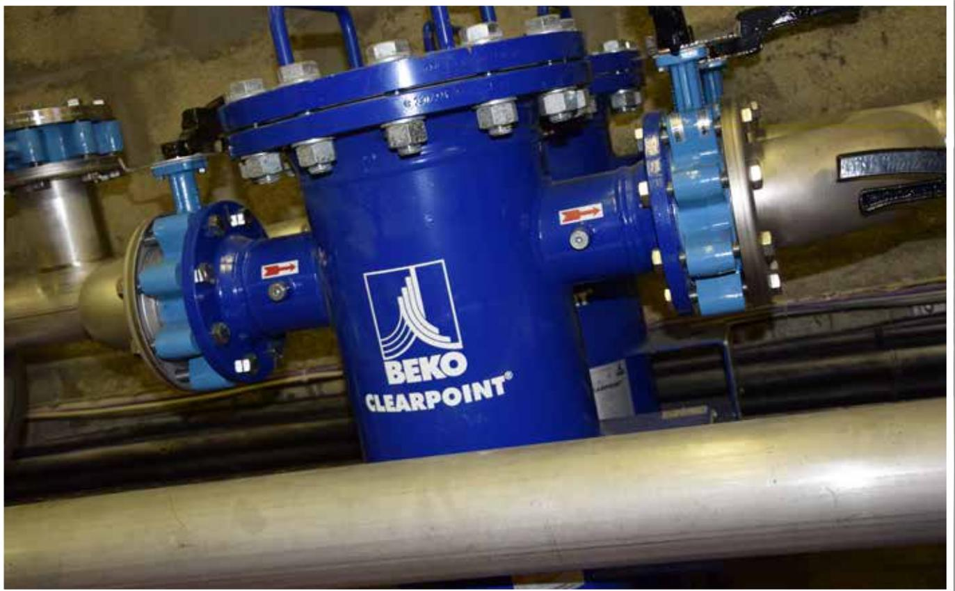
Le système de filtration CLEARPOINT installé chez le client lui permet d'éliminer efficacement l'eau, les particules solides, les poussières et l'huile contenues dans son réseau d'air comprimé
