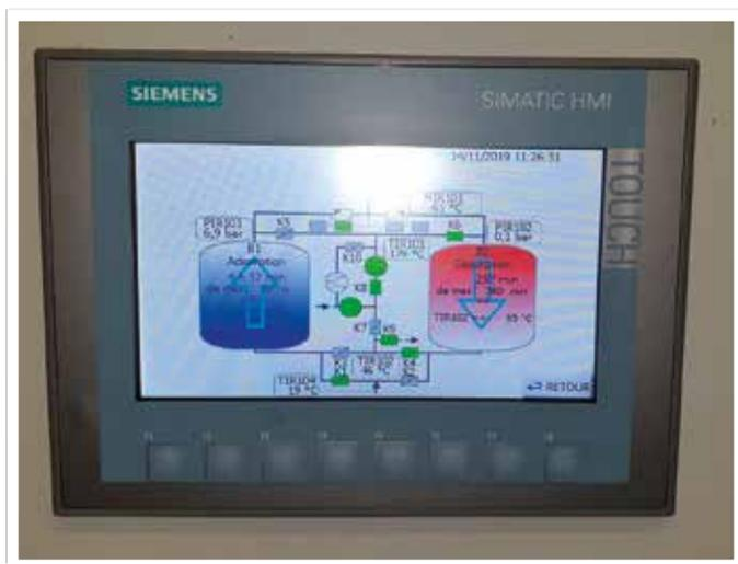
Le tableau de commande multifonction sert à gérer les fonctions du sécheur et du process tout en surveillant ses performances.
