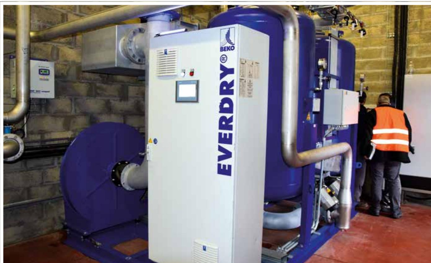
Le sécheur par adsorption à régénération par apport de chaleur EVERDRY® modèle FRL 5000, avec une capacité de séchage de 5000 m<sup>3</sup>/h et une pression de service de 6,5 bar, constitue le cœur de la nouvelle installation d'air comprimé.
