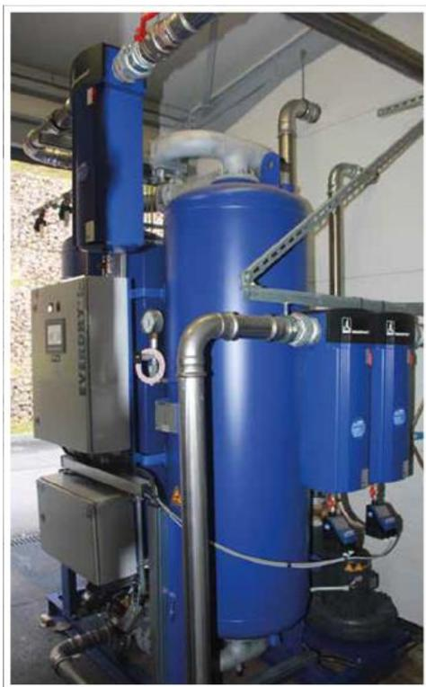
*L'essiccatore ad adsorbimento EVERDRY® tipo FRA-V rigenerato a caldo è il cuore dell'impianto di trattamento dell'aria compressa*
