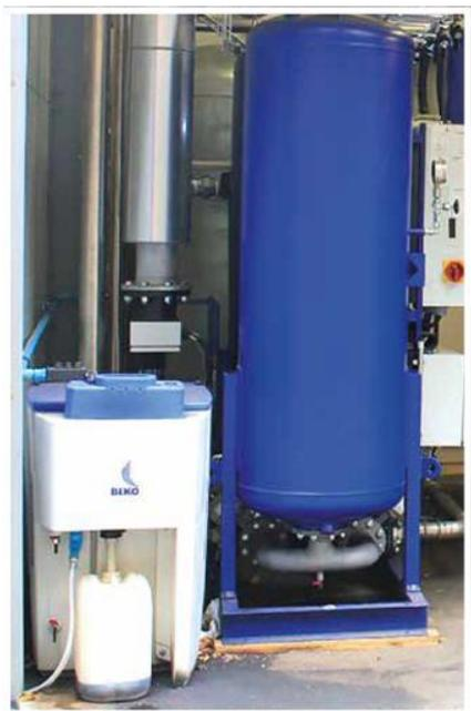
*Il separatore olio-acqua ÖWAMAT® raccoglie e tratta la condensa non emulsionata proveniente dal sistema d'aria compressa del cliente, indipendentemente dall'olio del compressore.*
