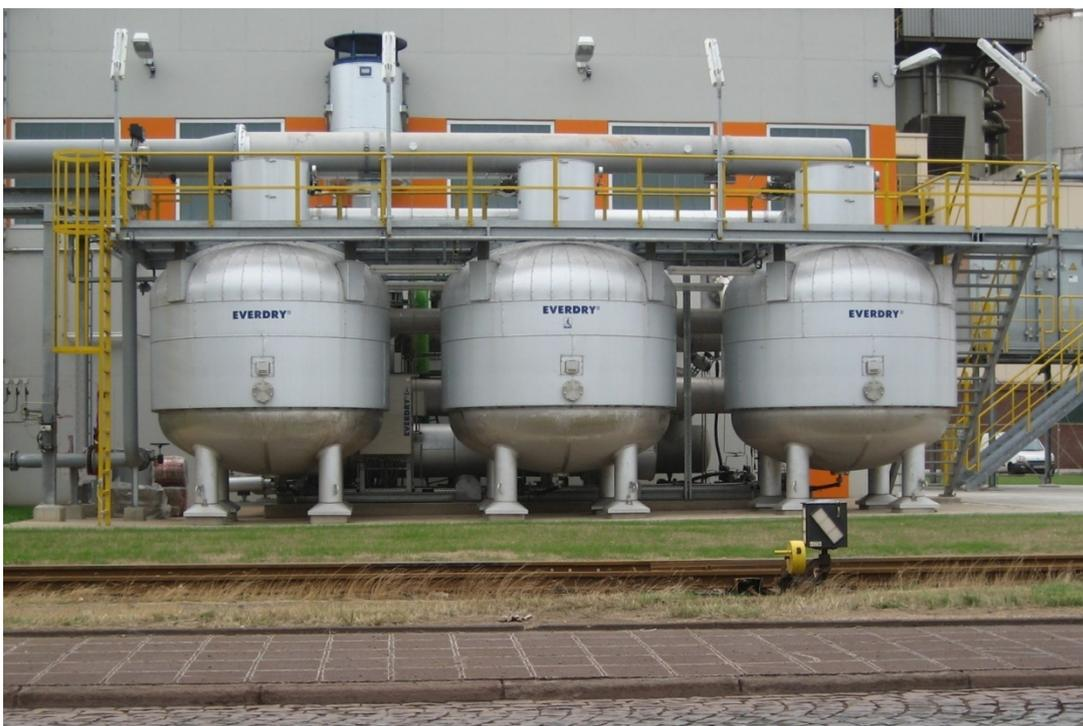
L'essiccatore ad adsorbimento EVERDRY HOC 65000 C si presenta inoltre come una specialità, poiché l'impianto non presenta due contenitori di adsorbimento, bensì tre, di cui sono sempre due in parallelo ad essiccare il flusso principale di aria compressa. Sempre il terzo contenitore viene prelevato, in cerchio, dal flusso principale, rigenerato e reso nuovamente "pronto" per il successivo processo di essiccazione. Il ricollegamento avviene mediante regolazione della potenza.
