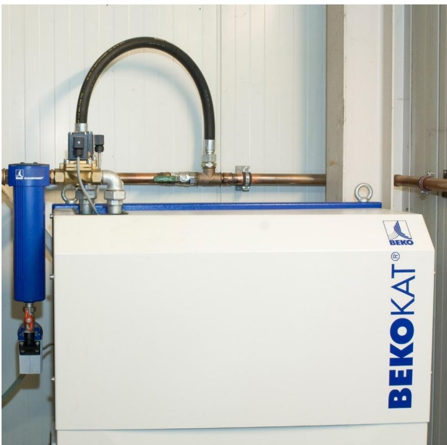
Con la procedura BEKOKAT è possibile, per la prima volta, ottenere un'aria compressa assolutamente priva di olio sempre con un contenuto residuo di olio massimo che non supera i 0,003 milligrammi per metro cubi di aria compressa. Una qualità, quindi, necessaria nei settori più esigenti della medicina e della farmacia, nonché nell'elaborazione e nell'imballaggio di alimenti.
