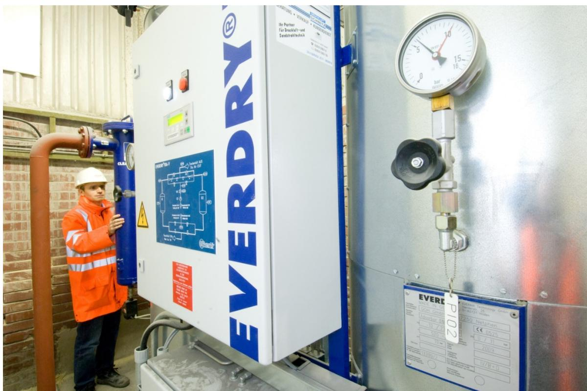
Il soffiatore di rigenerazione nel funzionamento a pressione provoca un aumento della temperatura, con effetto positivo per il fabbisogno energetico del riscaldatore. Il flusso d'aria ventilata vaporizza l'umidità acquisita nel materiale essiccante e infine viene avviato nell'atmosfera insieme al flusso d'aria. Il desorbimento avviene mediante flusso in controcorrente con ottimizzazione energetica.
