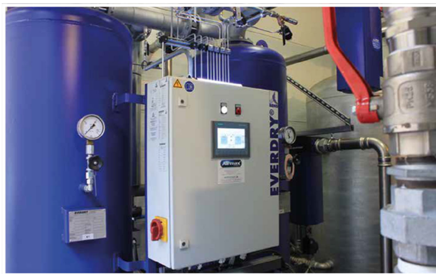
Fragment osuszacza adsorpcyjnego regenerowany na gorąco EVERDRY® typu FRA-V
