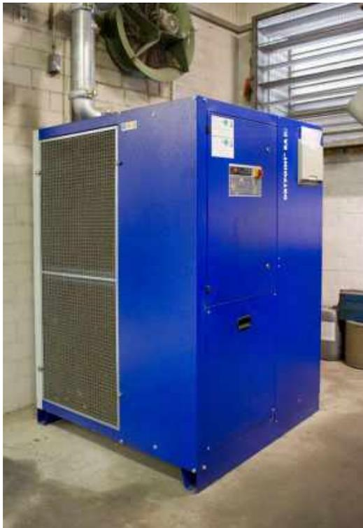
在DRYPOINT RA eco製冷乾燥機中，壓縮空氣乾燥是通過逆流過程，通過優化的熱交換貫穿整個過程路徑進行的，空氣流入向下對齊的運動，沒有任何不利的轉移。尺寸龐大的逆流熱交換器單元，包括空氣和空氣製冷劑熱交換器，可將壓縮空氣冷卻到大約攝氏3度的溫度，從而使熱交換器的安裝尺寸不僅促進特別有效的冷卻，但也將流阻最小化到絕對最小值。
